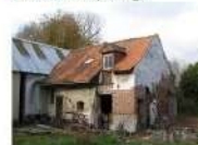
Unité bâtie 2 : Ancienne écurie
