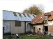
Unité bâtie 2 : orange/Ancienne écurie
