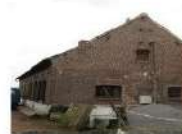
Unité bâtie 1 : Corps de logis
