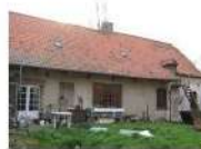
Unité bâtie 1 : Corps de logis
